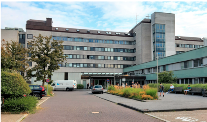
Alfried Krupp Krakenhaus, Essen (Germany)
